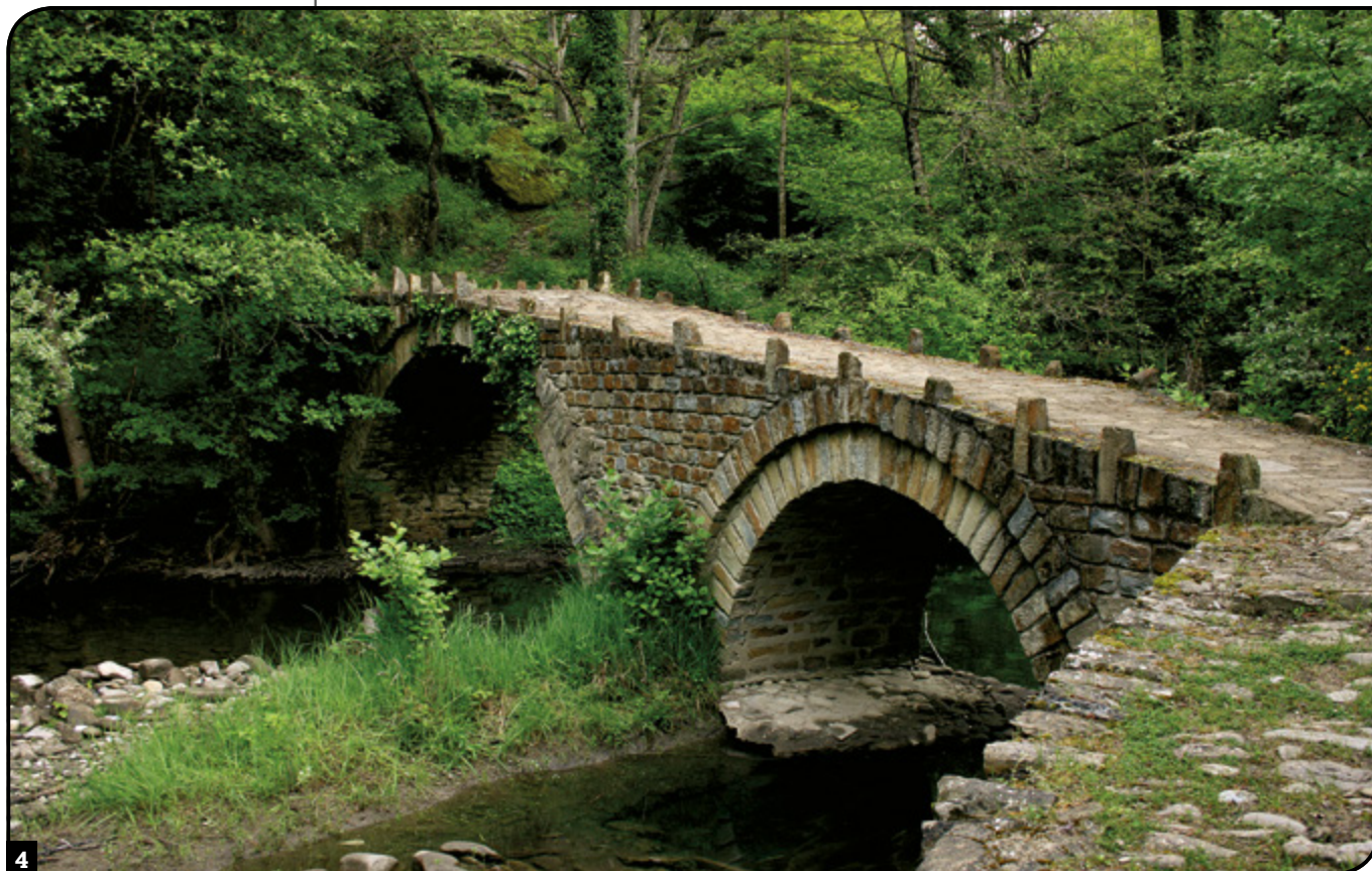
4: Λιθόστρωτο μονοπάτι που καταλήγει στο δίτοξο γεφύρι του Ντέρη (Μαρούτσου Θ. 2014).
